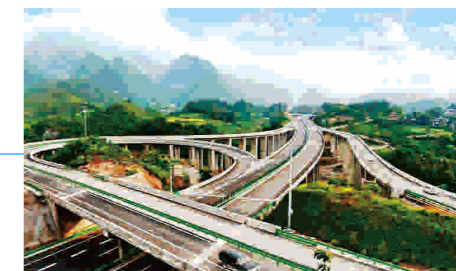
工程名称: 河南南阳浙川高速服务区 主机类型: WWM系列 Project name: Nanyang High speed service area WWM series WSHP
