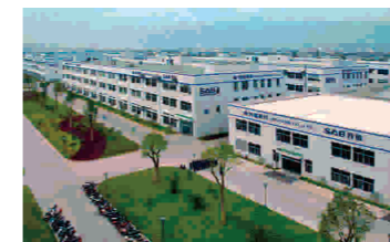
工程名称: 上海伟星管业工程 主机类型: VKC系列 Project name: Weixing pipe industry VKC series GSHP
