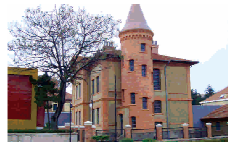
工程名称: 山东青岛法制教育基地 主机类型: VKC系列 Project name: legal Training Center VKC series GSHP
