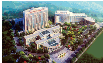
工程名称: 湖北黄冈英山县人民医院 主机类型: GSG系列 Project name: Hubei Huanggang People's Hospital GSG series Ground Source HP screw chiller
