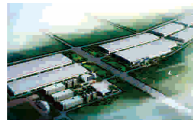
工程名称: 山东青岛软控胶州生产基地 主机类型: VKC系列 Project name: production base VKC series GSHP
