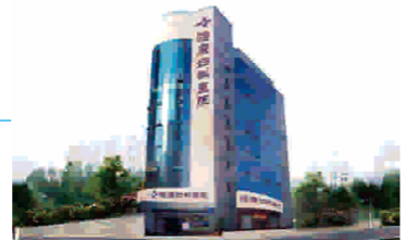
工程名称: 宁夏银川怡康妇产医院 主机类型: GSG系列 Project name: Yinchuan hospital GSG series Ground Source HP screw chiller
