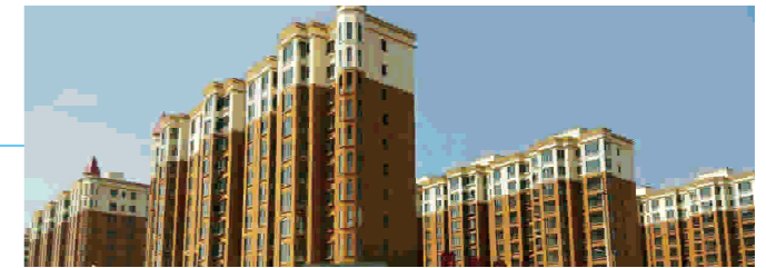
工程名称: 山西忻州盛世华城 主机类型: GSG系列 Project name: Shanxi xinzhou GSG series Ground Source HP screw chiller 建筑面积: 100,000m 2 装机容量: 2760kw Covered area: 100,000m 2 Capacity: 2760kw
