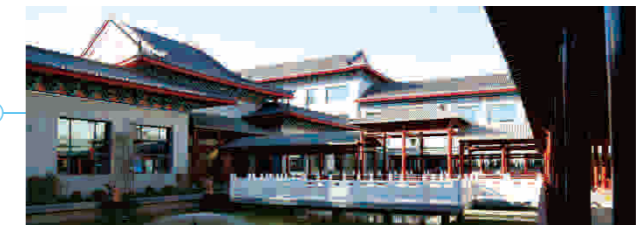
工程名称: 内蒙额济纳旗陶莱假日大酒店 主机类型: GSG系列 Project name: Garden Hotel GSG series Ground Source HP screw chiller 建筑面积: 21,000m 2 装机容量: 2330kw Covered area: 21,000 m 2 Capacity: 2330kw
