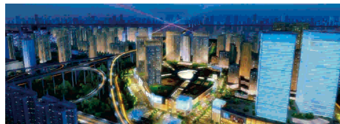
工程名称: 湖北武汉奥山世纪城 主机类型: GSG系列 Project name: Wuhan Century City GSG series Ground Source HP screw chiller 建筑面积: 1,500,000m 2 装机容量: 8160kw Covered area: 1,500,000m 2 Capacity: 8160 kw
