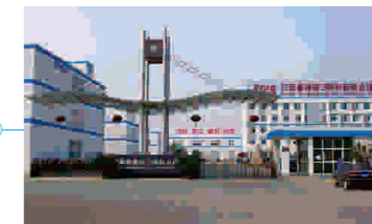
工程名称: 浙江宁波康强电子 主机类型: GSG系列 Project name: Kangqiang GSG series Ground Source HP screw chiller
