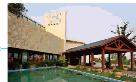
工程名称: 江苏吴江0572太湖温泉酒店 主机类型: GSG系列 Project name: 0572 hotel GSG series Ground Source HP screw chiller
