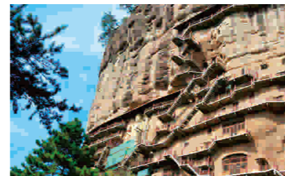
工程名称: 甘肃麦积山石窟艺术博物馆 主机类型: GSG系列 Project name: Maiji mountain Grotto art museum GSG series Ground Source HP screw chiller
