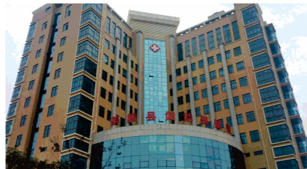
工程名称: 湖南株洲茶陵县妇幼保健医院 主机类型: GSG系列 Project name: Chaling Women & Children Care Hospital GSG series Ground Source HP screw chiller
