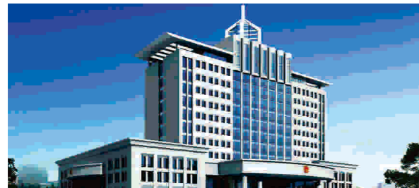
工程名称: 河南许昌人民法院 主机类型: GSG系列 Project name: Xuchang People Court GSG series Ground Source HP screw chiller 建筑面积: 14,000m 2 装机容量: 1400kw Covered area: 14,000 m 2 Capacity: 1400kw
