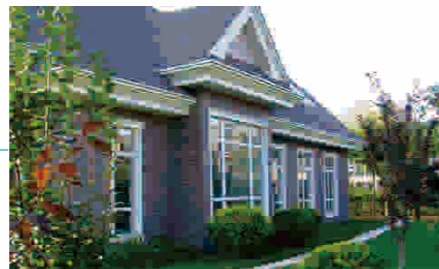
工程名称: 北京碧水庄园 主机类型: VKC系列 Project name: Beijing Bishui Manor VKC series GSHP
