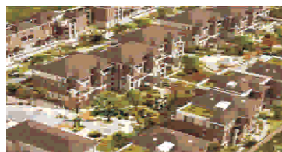
工程名称: 陕西西安曲江公馆 主机类型: VKC系列 Project name: Xi'an Qujiang House VKC series GSHP
