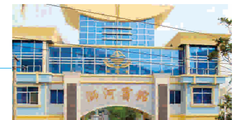
工程名称: 河南信阳沙河宾馆 主机类型: GSG系列 Project name: Xinyang Shihe hotel GSG series Ground Source HP screw chiller
