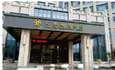
工程名称: 甘肃天水地质宾馆 主机类型: WWM系列 Project name: Tianshui Geological hotel WWM series WSHP
