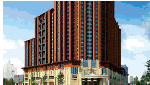
工程名称: 兰州临洮红星美凯龙 主机类型: WACM系列 Project name: Lintao Red Star Macalline WACM series Air cooled modular chiller
